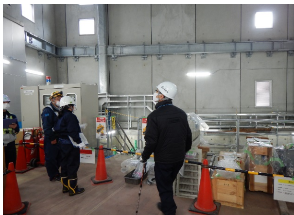
伊賀労働基準監督署とともに 工事現場をパトロールしました
