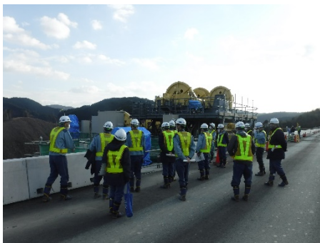
ダム堤頂管理設備の点検訓練
