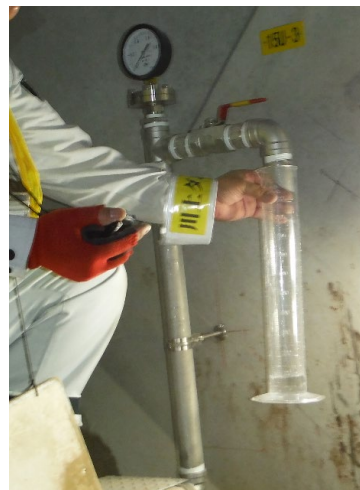
堤体内での観測 (漏水量観測)
